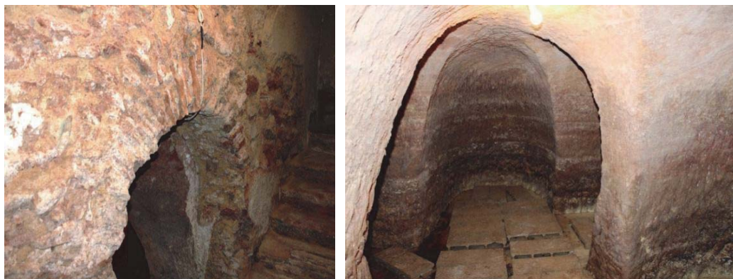
Galería subterránea con arco de medio punto. Casa lindera lado oeste y oquedad de la bodega
