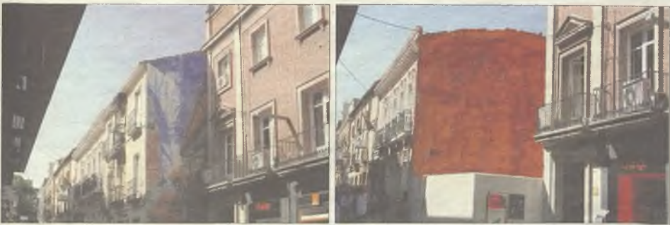
Mural de Bosch (calle Mayor) y aspecto actual tras derribarse el inmueble.
