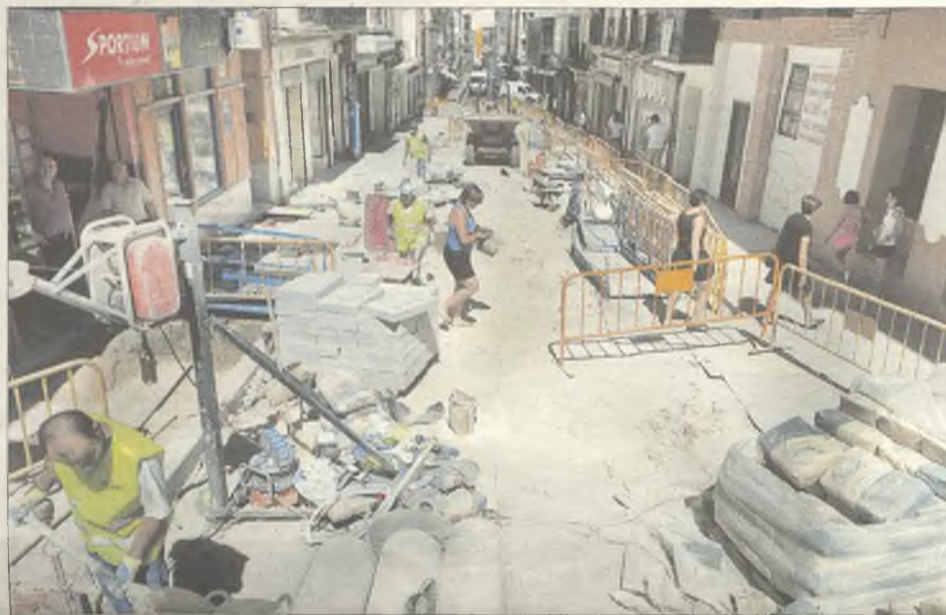
Las obras en Miguel Fluiters han dejado intransitables los accesos a los comercios.
