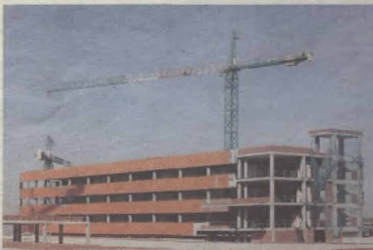
Las obras se reanudarán en el Hospital. /FOTO: EDUARDO BONILLA
