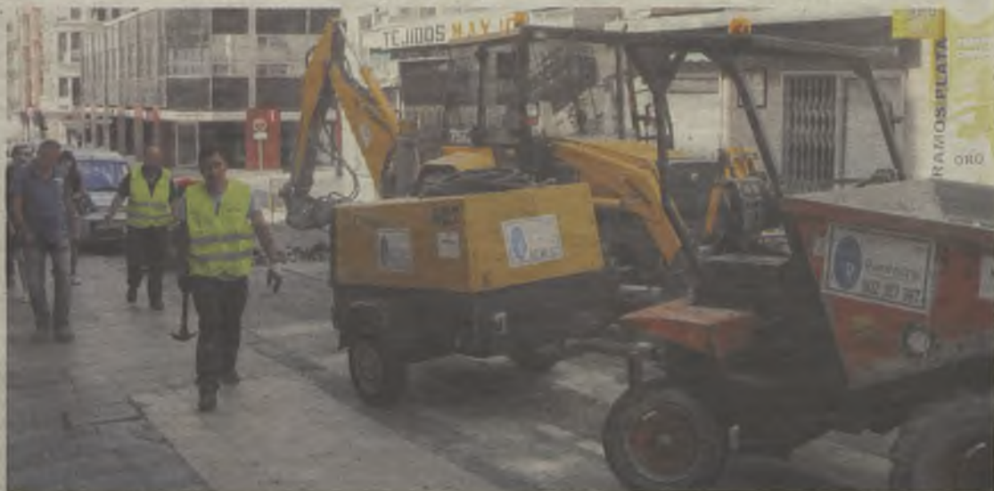
Las máquinas ya trabajan en la calle Miguel Fluiters. /FOTO: JESÚS ROPERO
