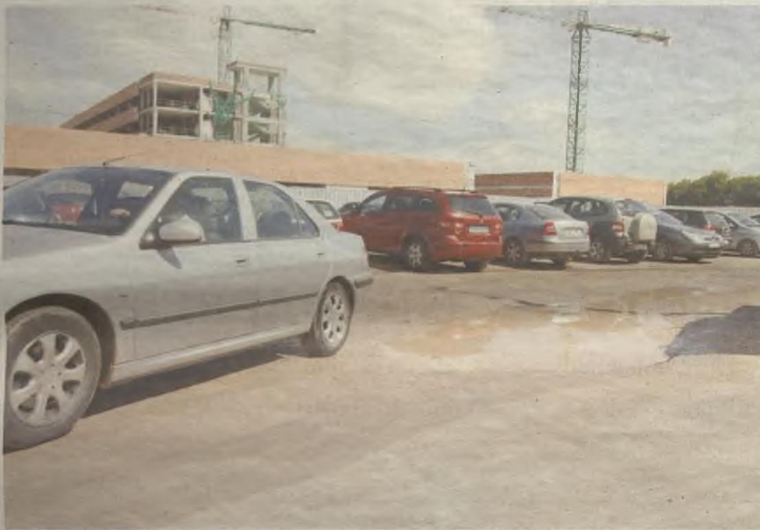
Esta zona quedará habilitada en tres semanas a partir del comienzo de las obras. / FOTO: EDUARDO BONILLA
