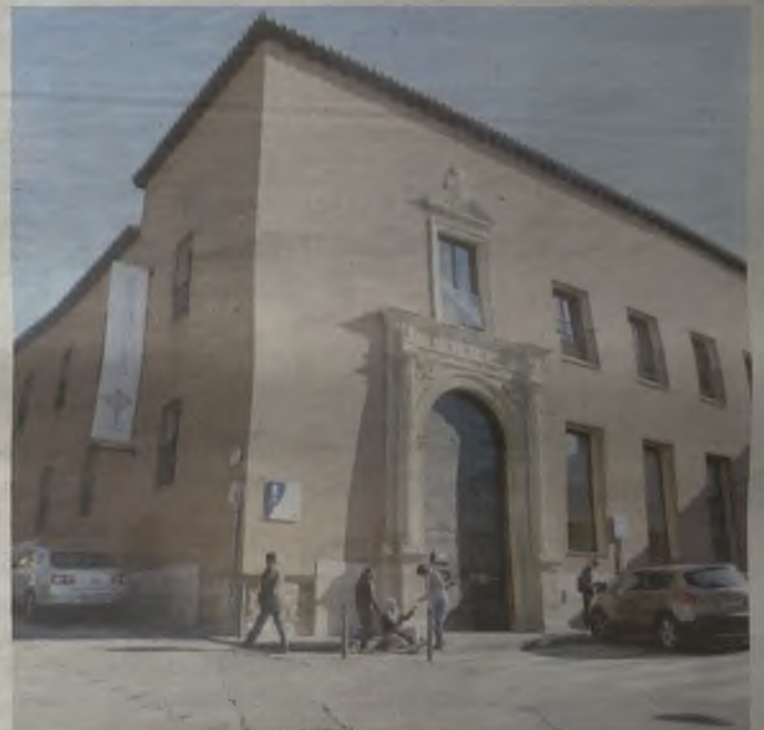
La Biblioteca Municipal, un hándicap para la obra de Dávalos.
