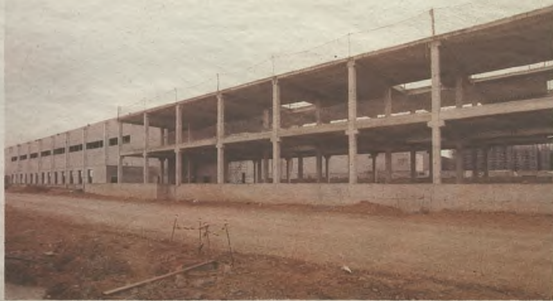
Las obras de esta gran nave avanzan a buen ritmo./ FOTO: EDUARDO BONILLA
