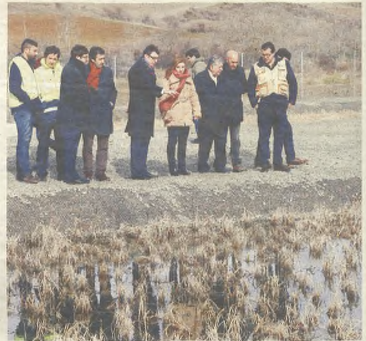
La planta de Atienza depura a través de plantas que imitan el proceso natural.
