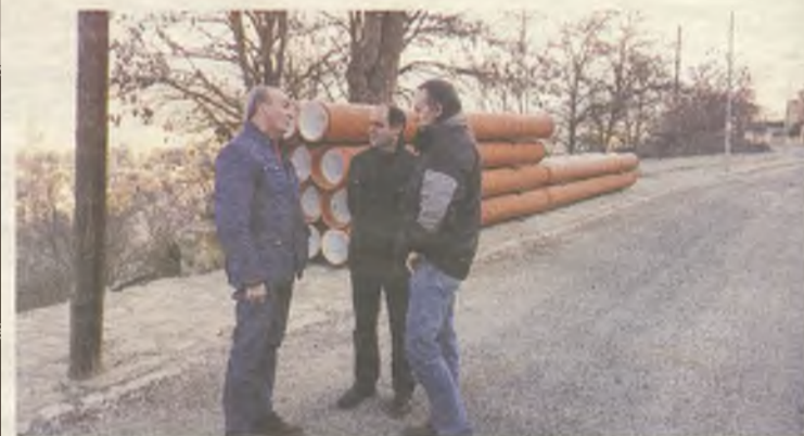
El Diputado de Infraestructuras ha visitado las obras del entorno de Sigüenza.
