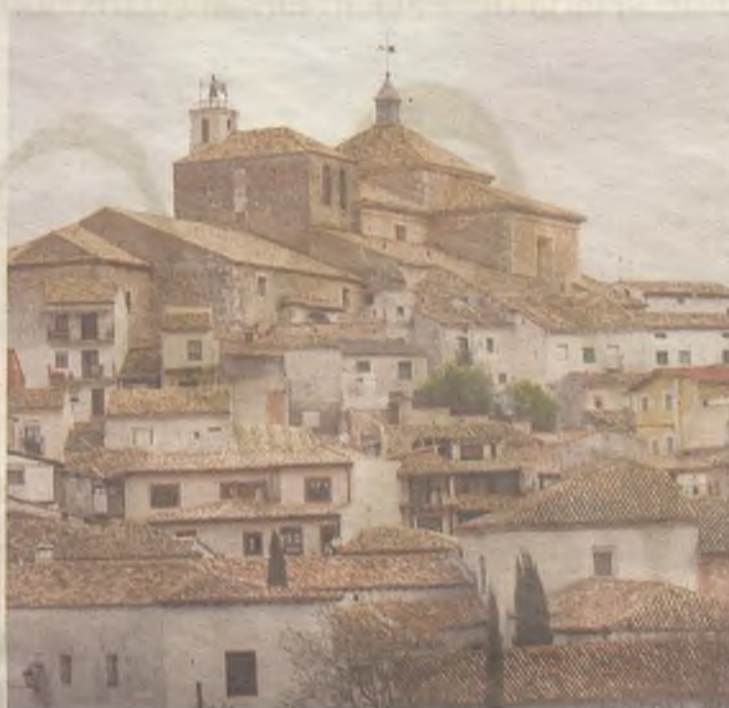
La Colegiata, elevándose sobre el resto de construcciones pastraneras.
