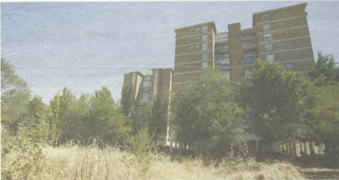
Zona en la que se ubicará el futuro parque de Las Torres./Eduardo Bonilla
