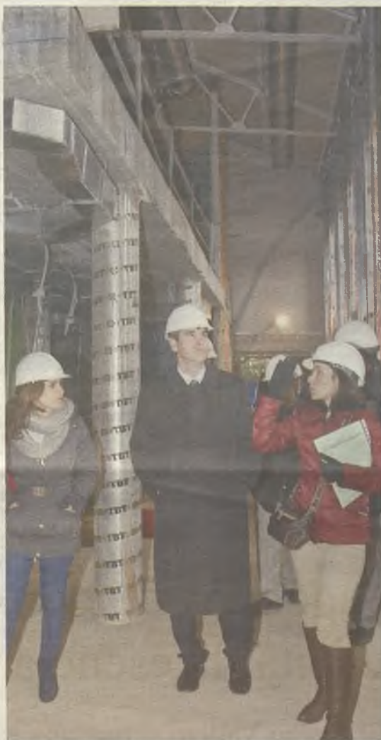
El alcalde visitando las obras./J. Ropero
