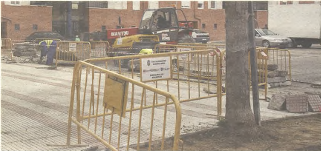
Ya han comenzado las obras en la plaza de La Paz./J. Ropero
