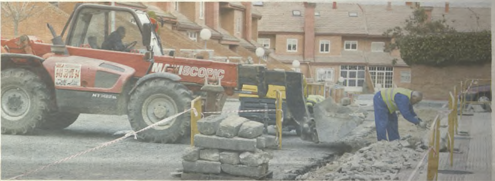
Las primeras obras ya han comenzado en la plaza de La Paz./J. Ropero
