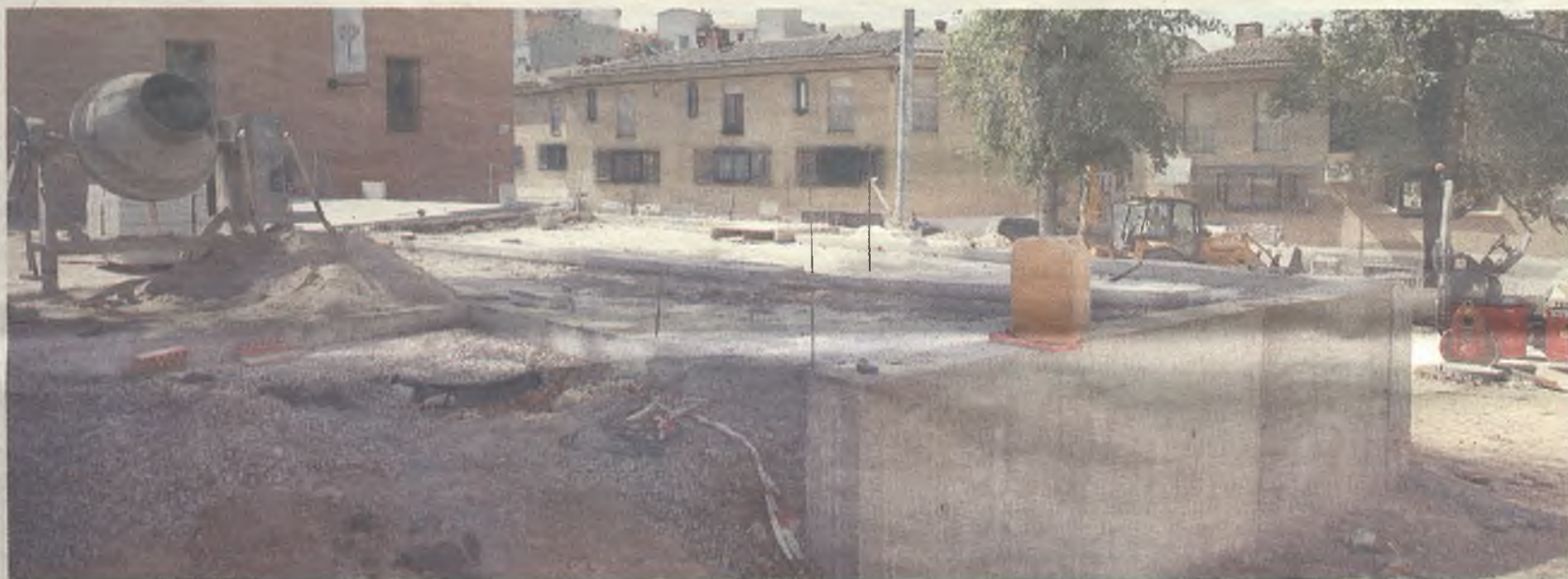
Vista de las obras en la plaza de Dávalos./E. Bonilla
