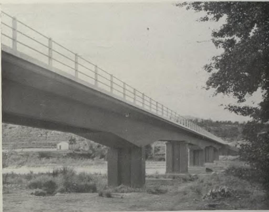
sobrecarga correspondiente al tren tipo n° 1 de la Instrucción Oficial, o sea la de una apisonadora de 20 toneladas y sobrecarga uniformemente repartida delante y detrás de 450 kilos por metro cuadrado.
