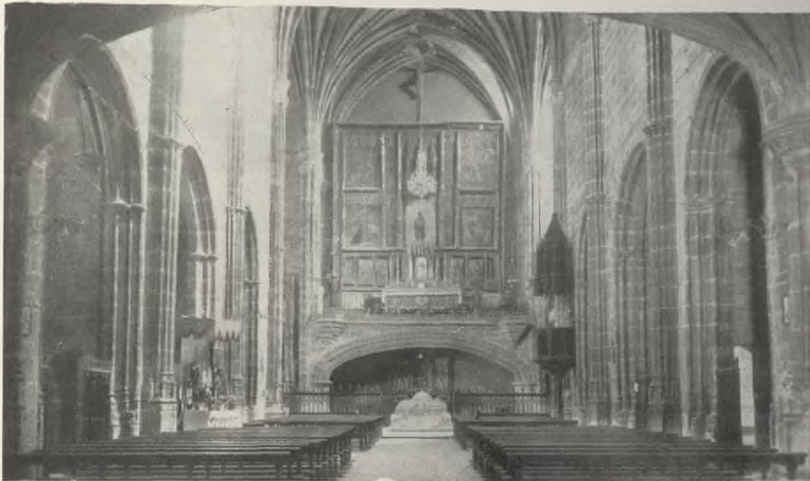
AVILA.—Convento de Santo Tomás. Vista del interior.
