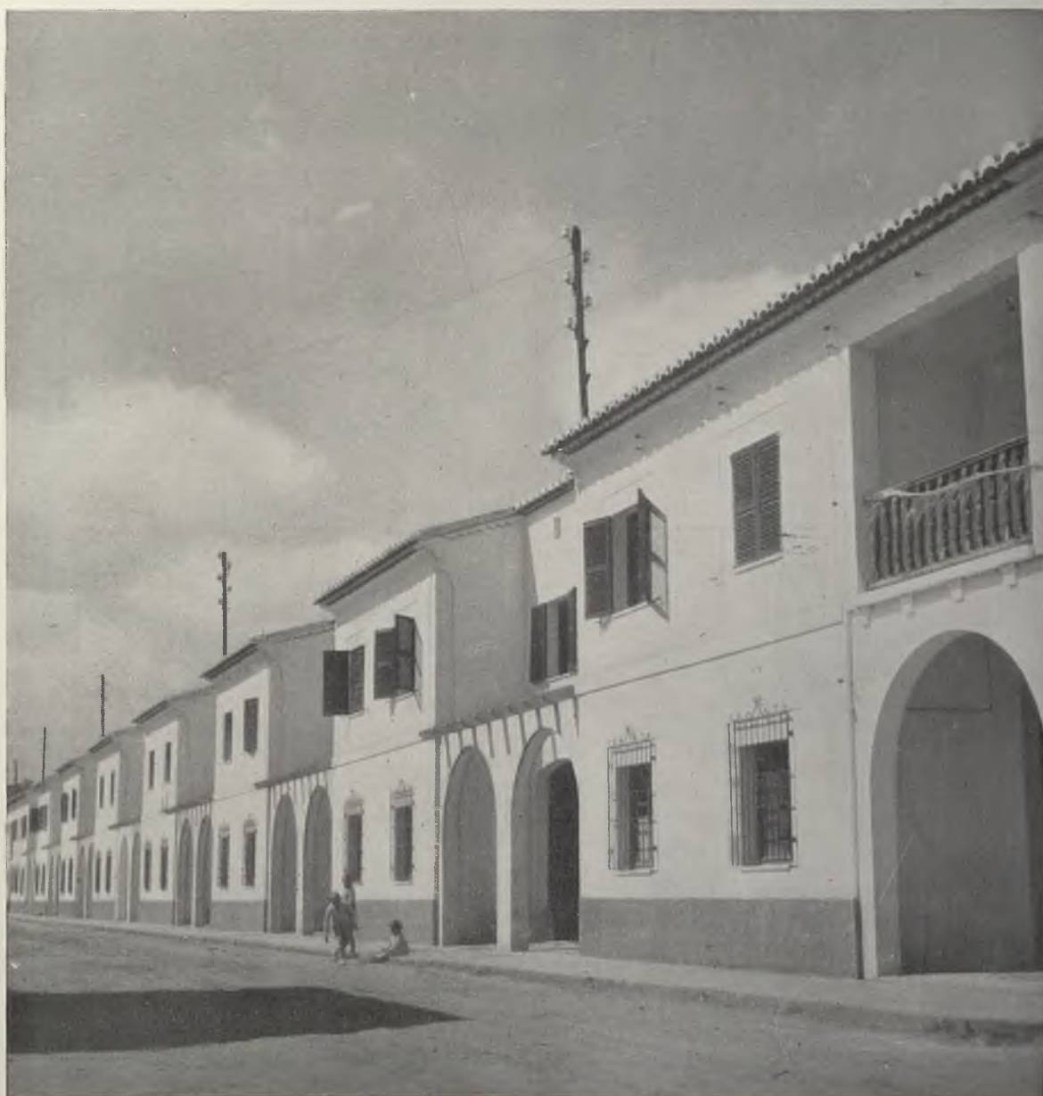
Castellón. CHILCHES.—Viviendas para labradores.
