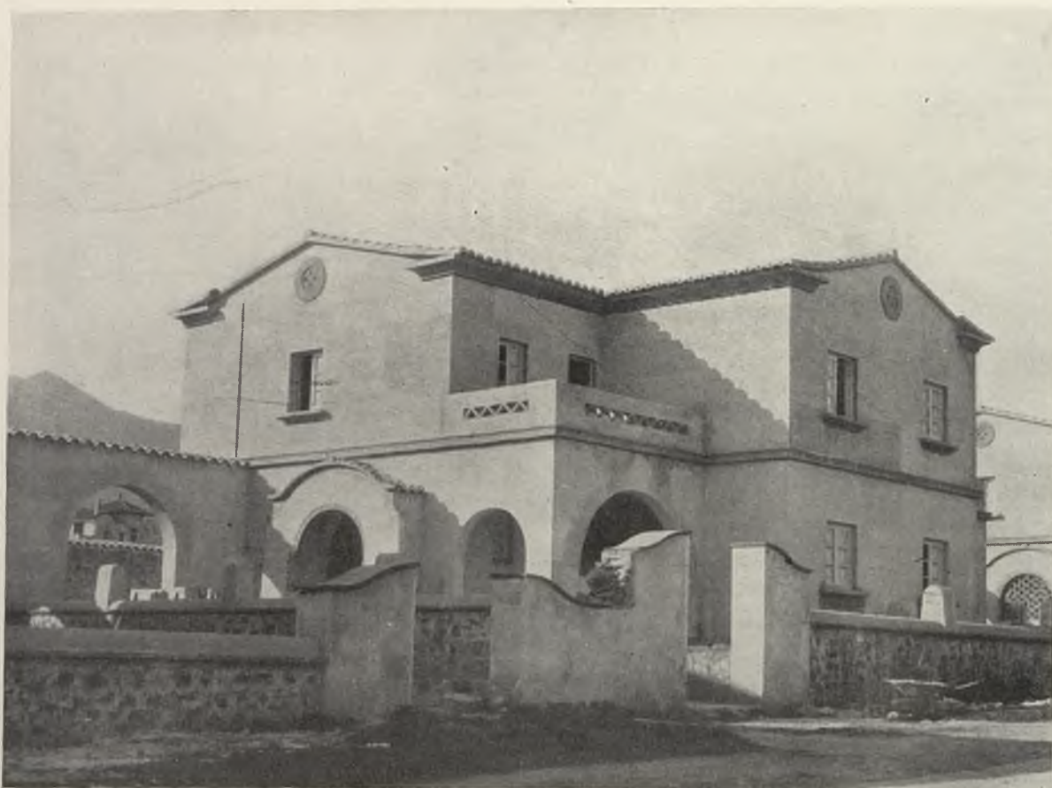
Castellón. VALL D' UXO.—Viviendas para maestros.
