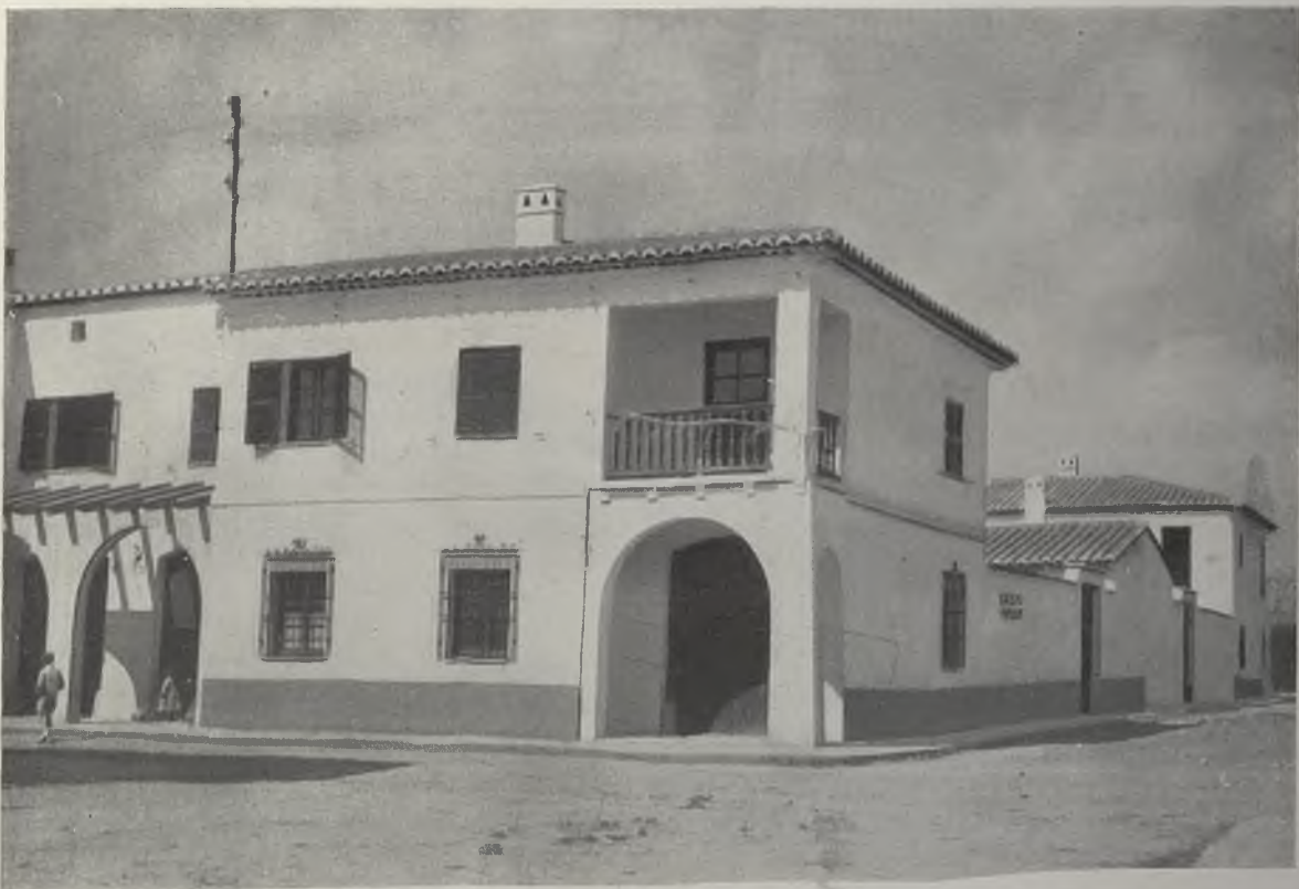
Castellón. CHILCHES.—Viviendas para labradores.
