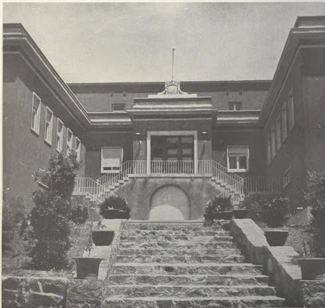
PALAMOS.—Hospital. Entrada principal.
