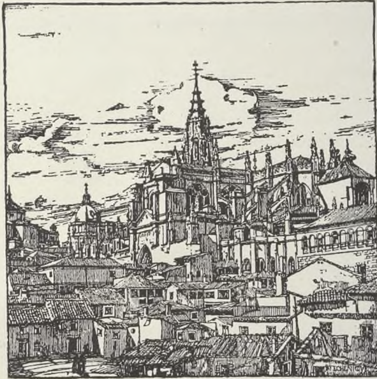
Fig. 6.—D. Francisco Echenique, arquitecto.
