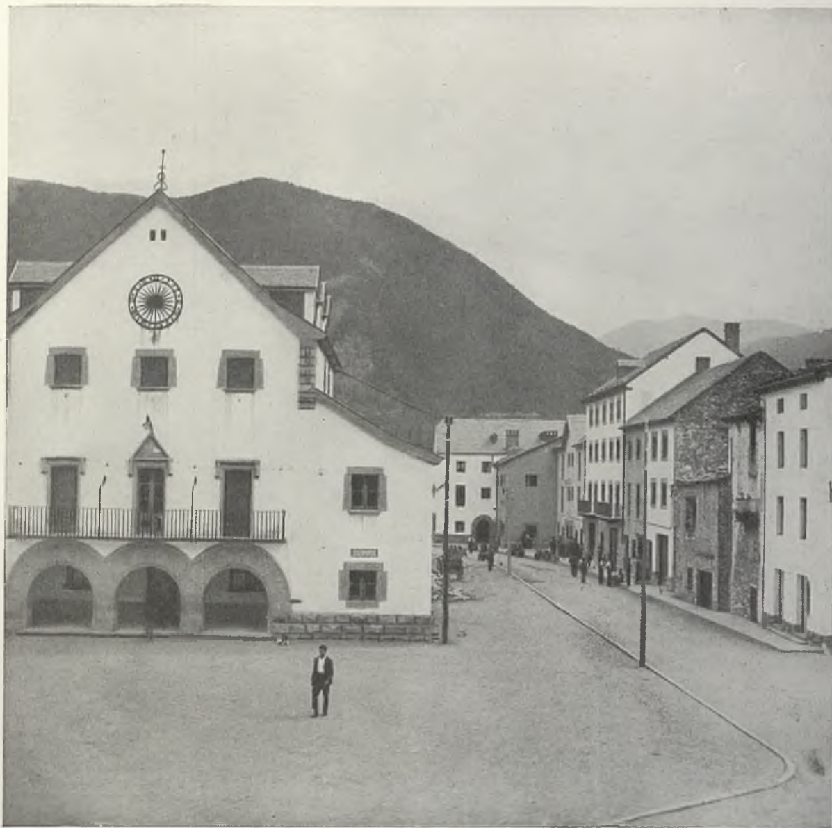
BIESCAS.—Ayuntamiento, plaza y viviendas.
