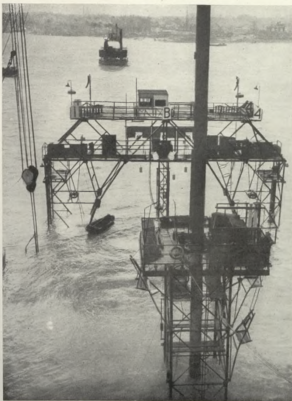
La pieza del túnel en su sitio.
