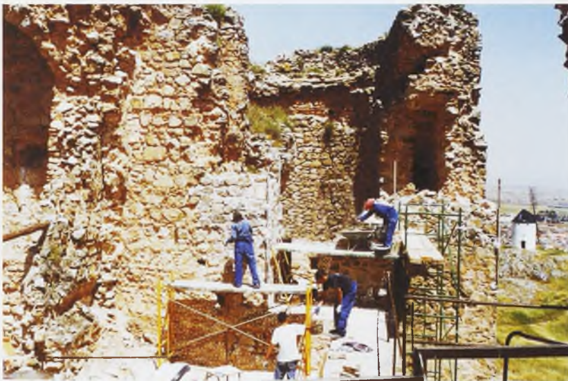
Restauración del torreón Norte del Castillo por la Escuela Taller en el verano de 1986. Foto: Julio García Ortiz.
