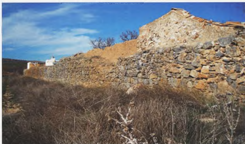
La presa romana de Consuegra que muestra como las casas de labranza se apoyan en el muro del monumento. Lado oeste o de aguas arriba. (Foto Juan Palencia)
