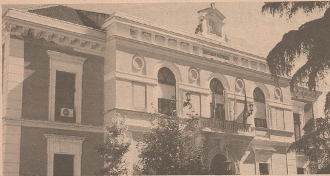
Fachada principal del edificio que alberga la Diputación Provincial de Guadalajara. / Economía de Guadalajara
