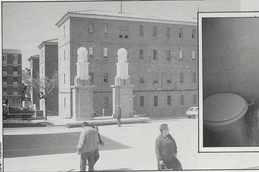
En total 200 viviendas de «Corea» cuentan con unos ventanucos en lugar de ventanas y la superficie del piso no supera los 40 metros cuadrados.
