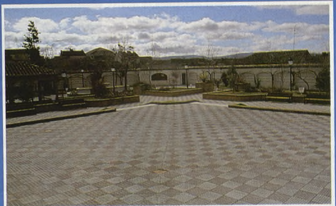
Trabajos de impermeabilización de terrazas, patios, paseos...
