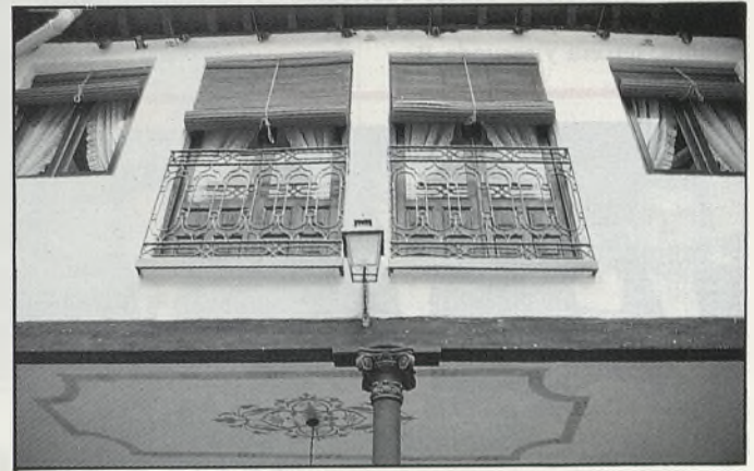
Detalle del patio principal: los dibujos del techo también aparecieron en una reciente reforma.
