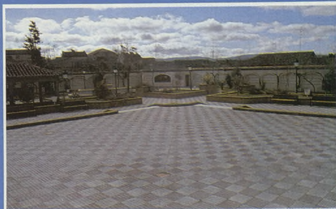
Trabajos de impermeabilización de terrazas, patios, paseos...
