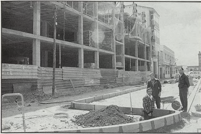
APARCAMIENTO. En Torrijos se están ultimando los trabajos para construir una zona de aparcamiento en la Avenida del Generalísimo, antigua Calle de la Estación. La inversión total de las obras de la citada vía, que está siendo pavimentada, asciende a casi 100 millones de pesetas.
