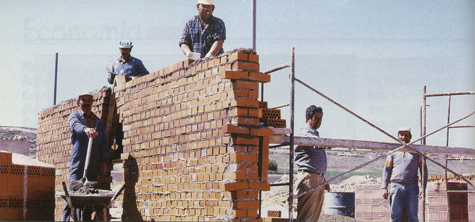
Tras un periodo de estancamiento, muchos promotores se han lanzado a la construcción de viviendas.
