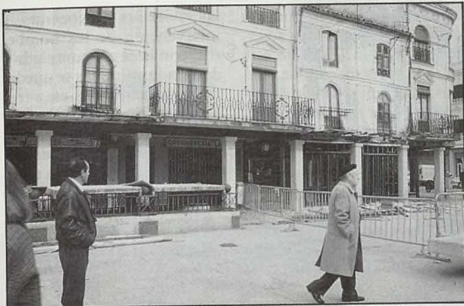
El Ayuntamiento no controla todos los inmuebles que amenazan ruinas y de vez en cuando se producen las sorpresas.
