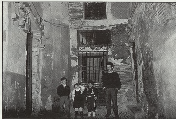
San Justo es uno de los barrios de Toledo que mayor ruina presenta. Son viejas casas de barro que esperan pacientemente ser demolidas o que el tiempo acelere lo que la Administración para el derrumbe. Mientras muchos ciudadanos por un módico alquiler arriesgan su vida viviendo en ellas, como la familia de Remedios (en la foto) que se le cayó la casa encima.
