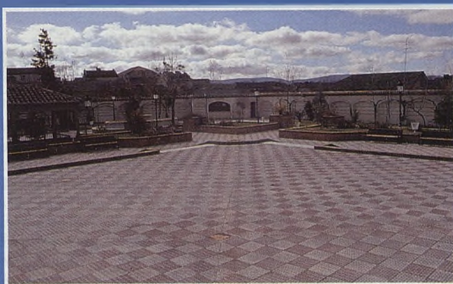
Trabajos de impermeabilización de terrazas, patios, pasarelas...
