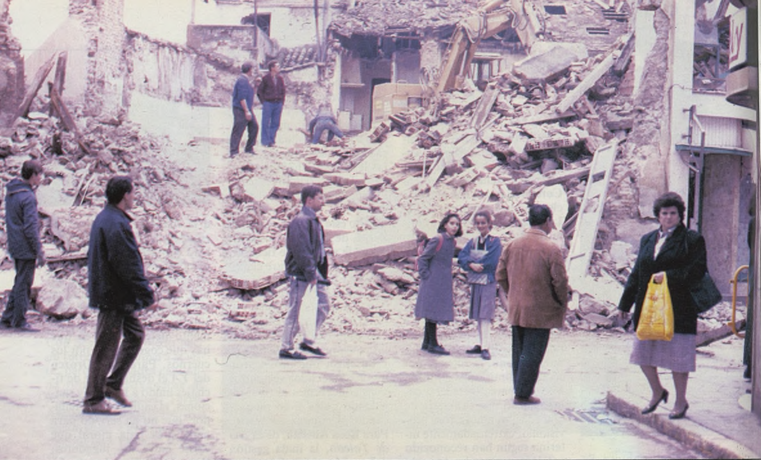
En Ciudad Real se han demolido en los últimos tres años más de cien casas.
