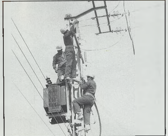
TRABAJO CON RIESGO. Siempre habrá trabajos que impliquen riesgo para como el de estos instaladores del tendido eléctrico que a pleno sol, colocaron un transformador cerca de la localidad de Rielves para las nuevas instalaciones de la factoría Hierros Torrijos.
