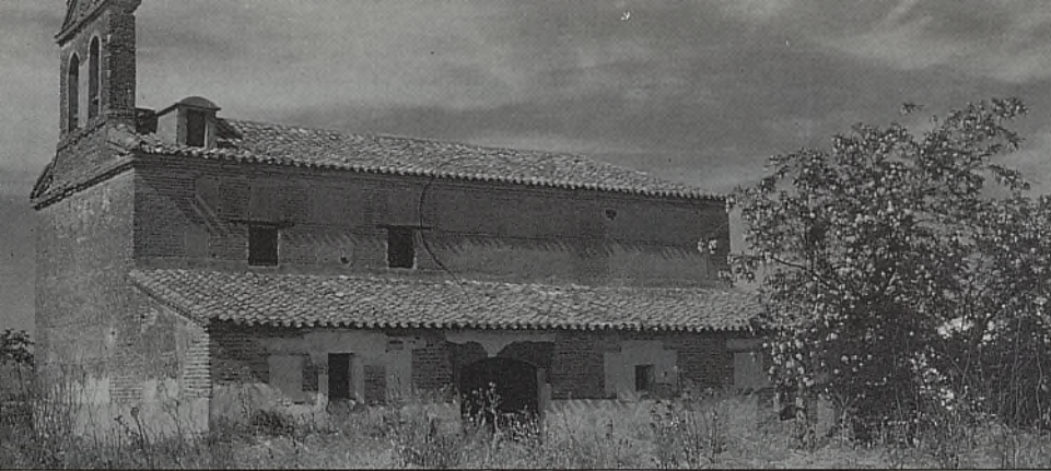
Las cuatro casas que existen en el municipio están amenazadas de ruina, y hasta el templo parroquial se está derrumbando.
