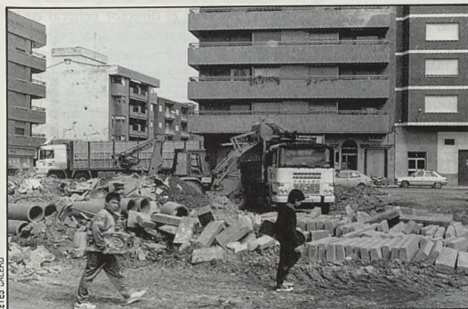
ENFRENTAMIENTO. Las obras de la plaza de Plá y Daniel de Torrijos, mantienen enfrentados al actual alcalde de la localidad, Miguel Angel Ruiz-Ayúcar y al candidato independiente a la alcaldía en las próximas elecciones, Isidro del Río. Este, cree que la plaza es el lugar idóneo para construir un aparcamiento, mientras que el alcalde opina que el coste sería muy elevado. Las obras de Plá y Daniel cuentan con una inversión de 20 millones de pesetas.
