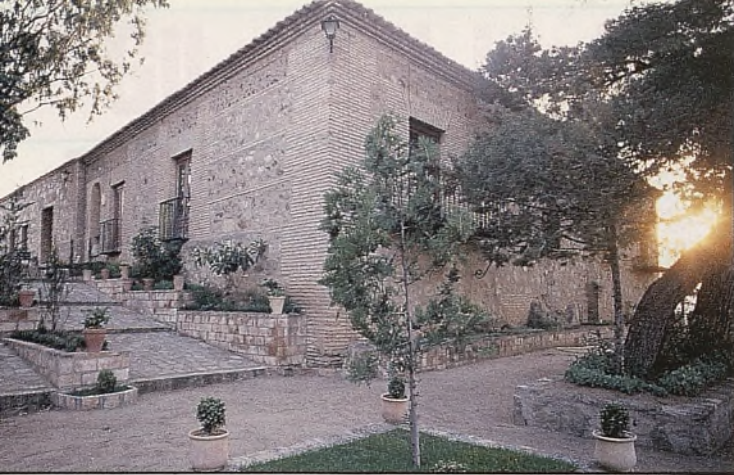
Vista general de un ángulo de la casa construida hace más de 200 años.
