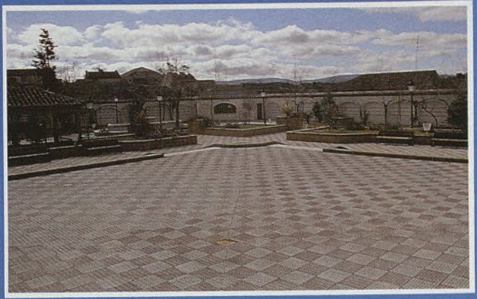
Trabajos de impermeabilización de terrazas, patios, paseos...
