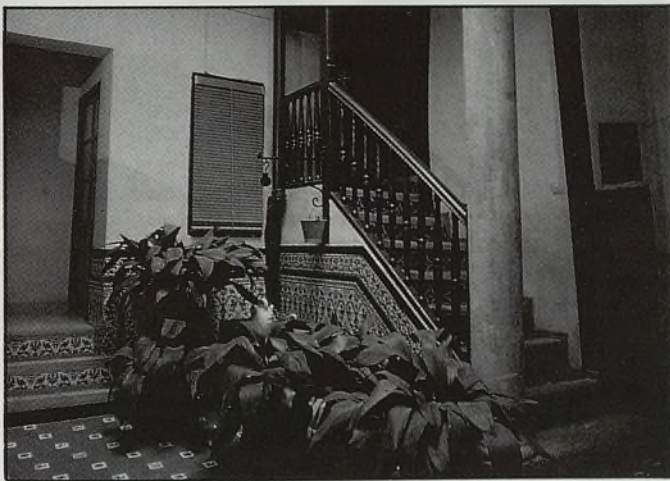
La Posada del Estudiante, situada en el callejón de San Pedro, fue comprada hace tres años en estado ruinoso. En la restauración a cargo de su propietario, constructor de profesión, se ha conservado la tradición hasta el mínimo detalle.
