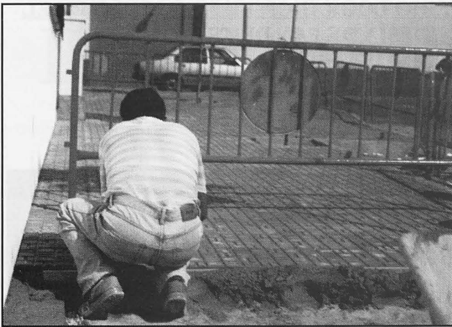
...La Avenida de la Libertad , en el Polígono A, está a punto de finalizar su urbanización. En la imagen, trabajadores colocan las losetas del acerado.
