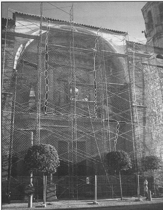
Entrada principal en un momento de la restauración.
