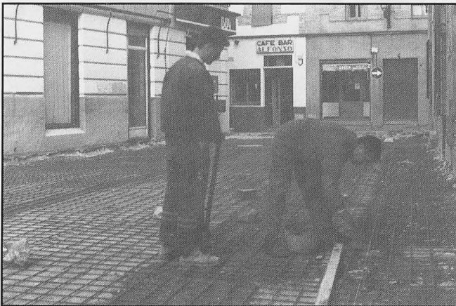
Un momento de las obras
