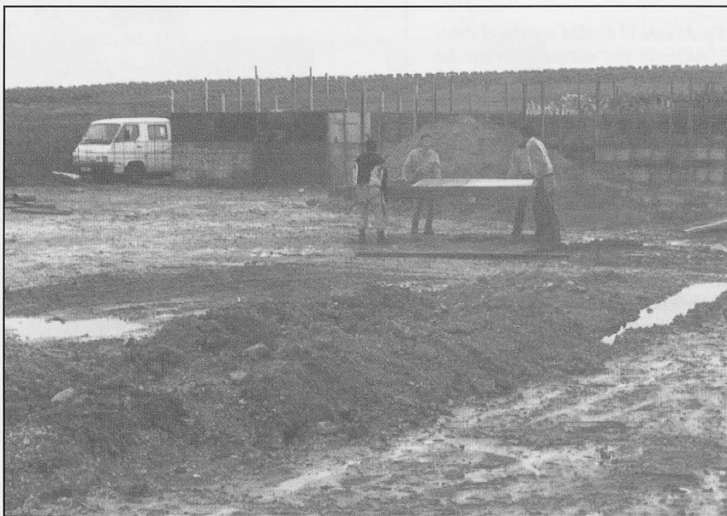
Estado de las obras de lo que será la nueva factoría de 1.250 m 2
