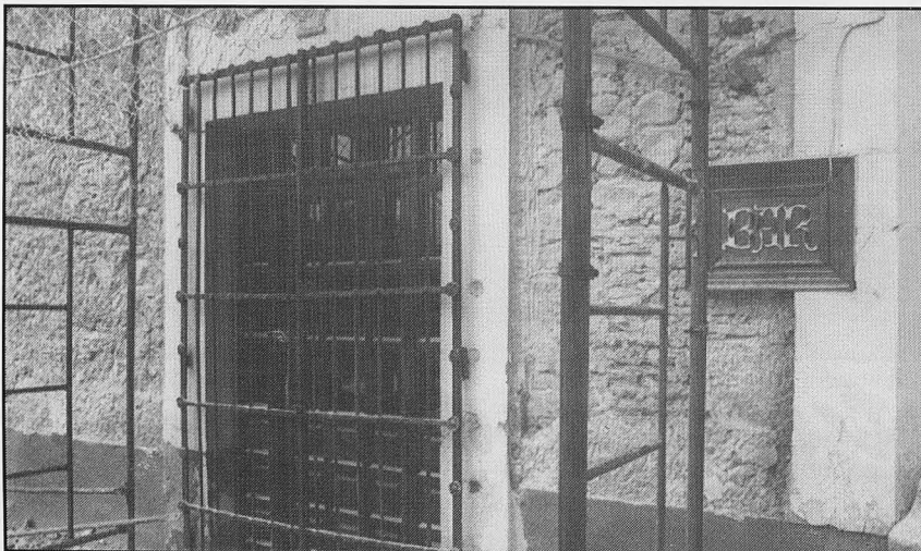
Fachada del Bar-Restaurante Don Diego
