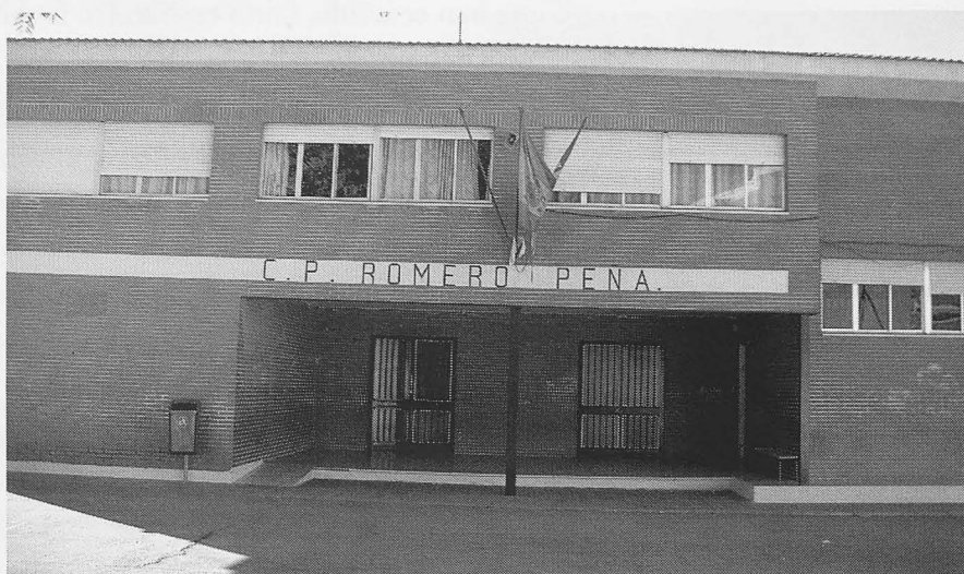
Fachada principal del colegio.
