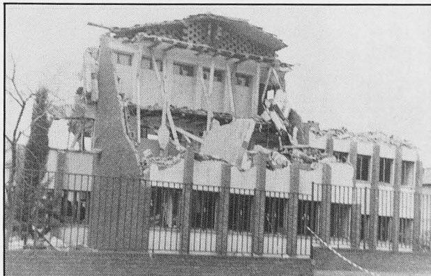
El viejo edificio del Colegio Sagrado Corazón derrumbado
