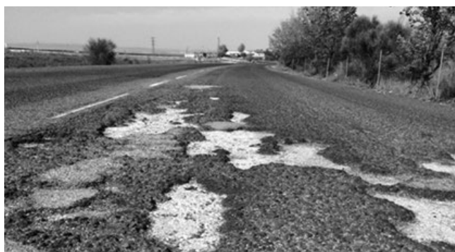
▲ Aspecto de los accesos de la variante antes del bacheo.
