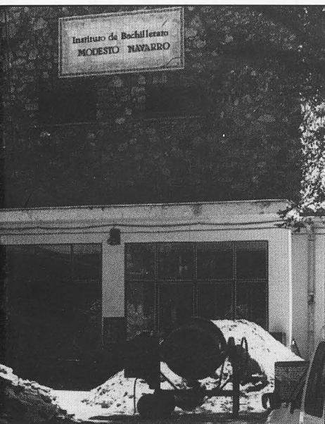
obras de rehabilitación.
