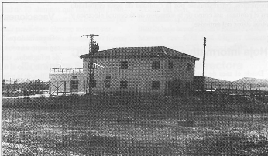
Depuradora de aguas de La Solana
