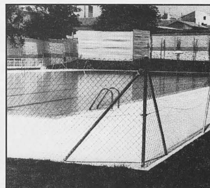
Otra imagen de la instalación.
