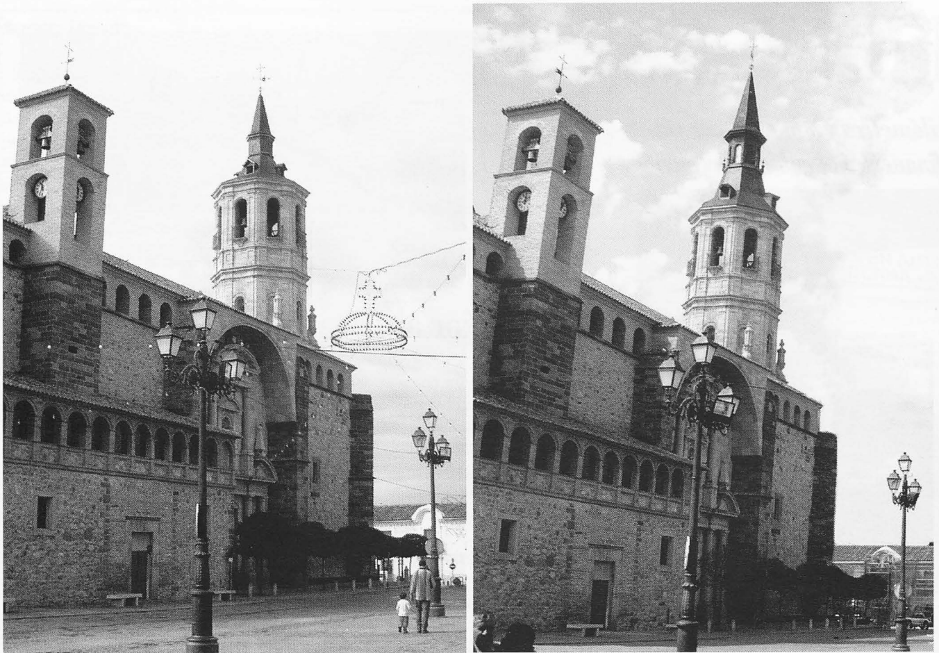
Antes y después de las obras de rehabilitación de la torre de la iglesia de Santa Catalina.
