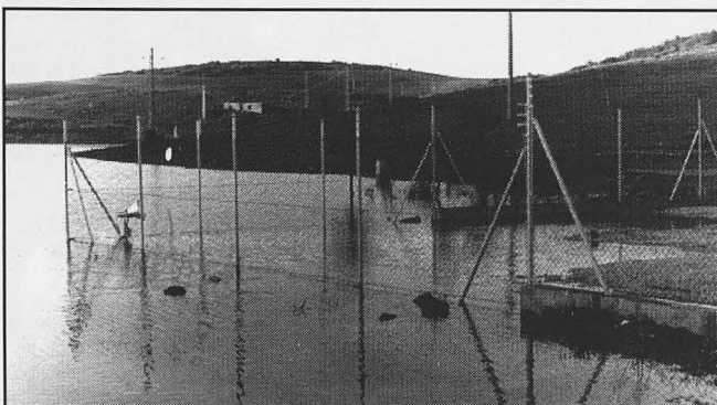
La estación de Unión Fenosa llegó a estar así de inundada
