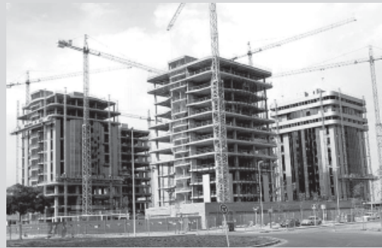
Obras de la construcción en Marruecos
