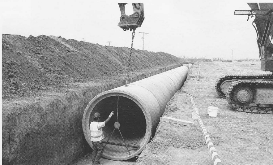
Obras del colector aliviadero de La Veguilla.
