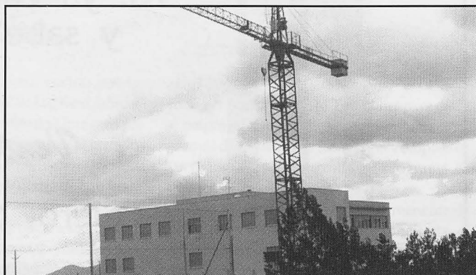
Las obras siguen para futuras ampliaciones.
