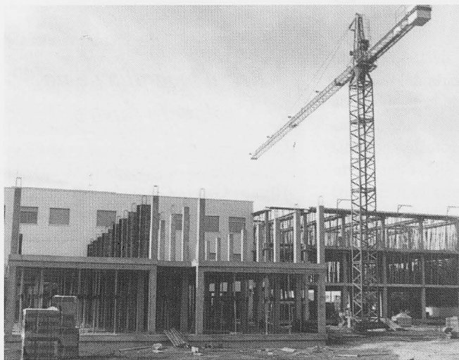
Estado actual de las obras de ampliación.
