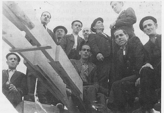
Santa Catalina. Ahora que Santa Catalina está en obras traemos la imagen de estos solaneros finales de los años 40 cuando se reconstruían las bóvedas del templo.
