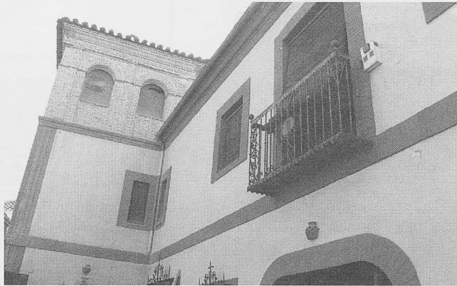
Fachada principal con el torreón al fondo.
