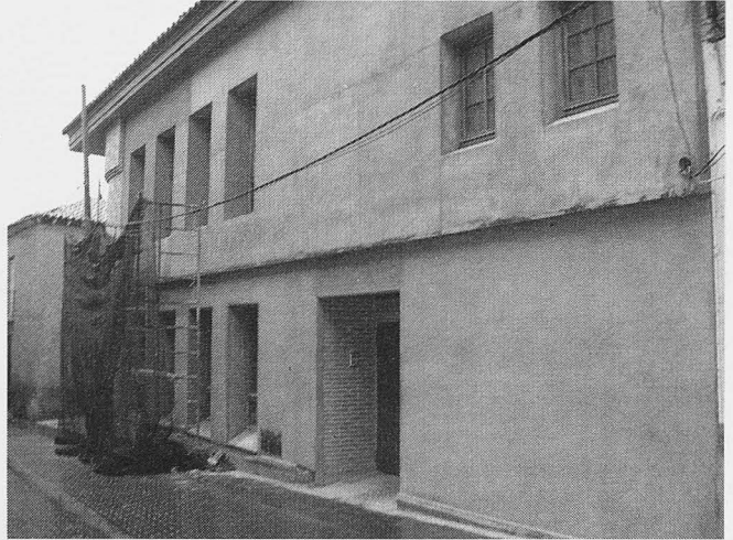
Así está quedando la rehabilitación de la fachada.
