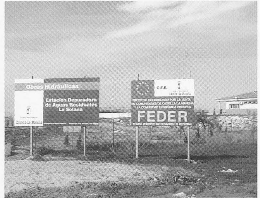
Depuradora de aguas residuales.
