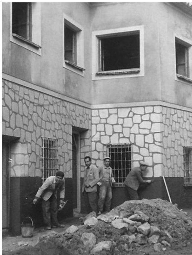
▲ Obras calle Borja. Años 60.
