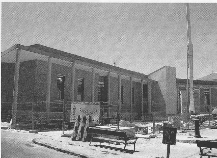
Obras del nuevo edificio del Mercado Municipal de La Solana.
