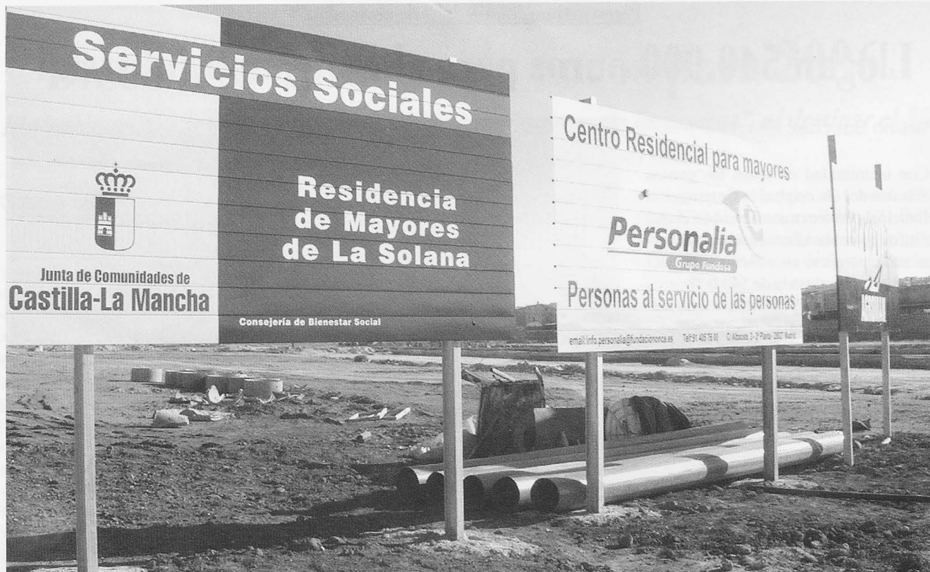
Aquí se construirá el nuevo geriátrico.
