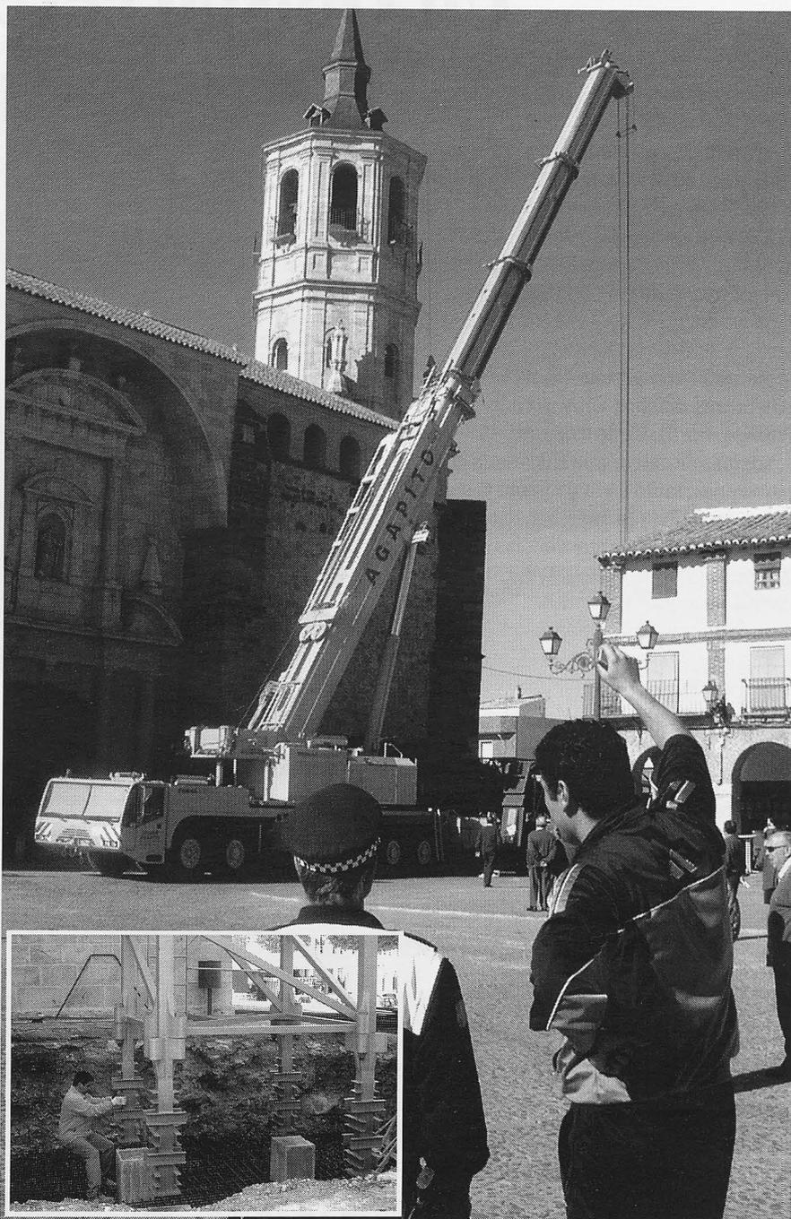
Imagen de las obras del chapitel y detalle de los cimientos de la grúa auxiliar.
