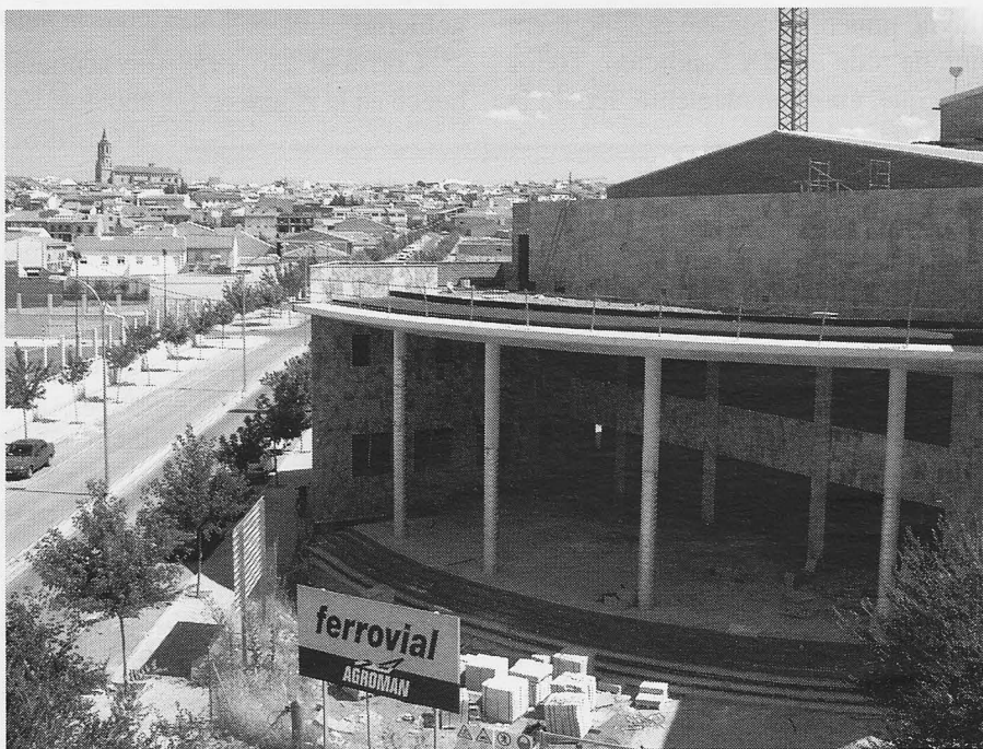
Imagen de las obras del Teatro Municipal Tomás Barrera de La Solana.
