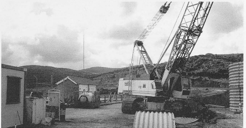
Trabajos de reparación en la presa.
